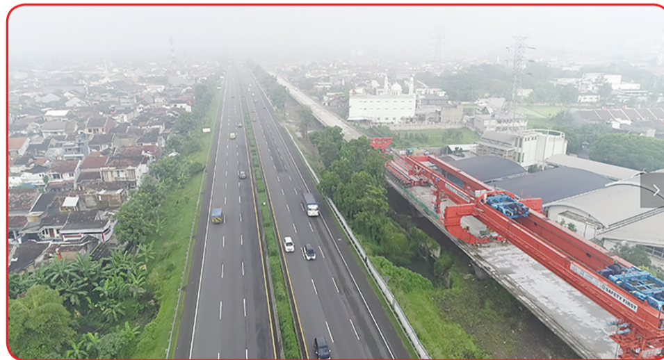
Pemasangan box girder Jalur kereta cepat Jakarta - Bandung Trase Bandung.
